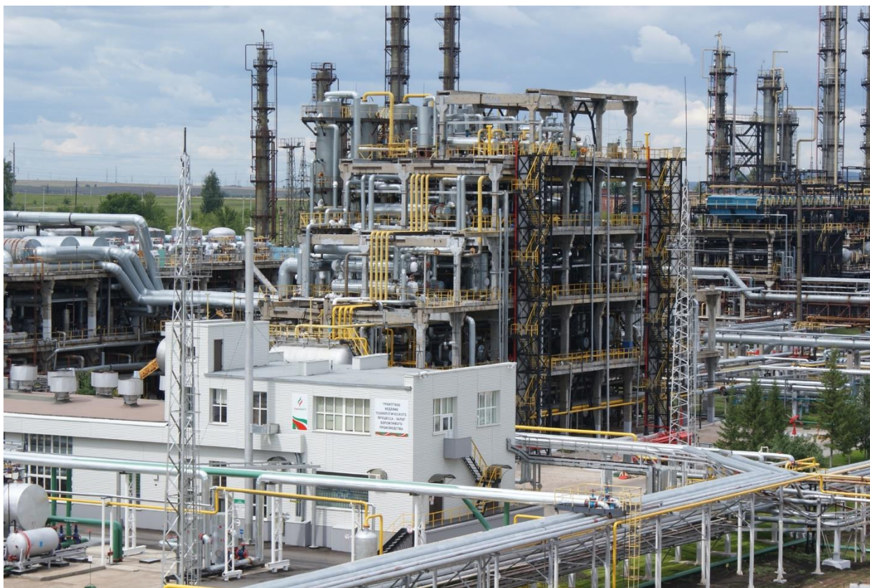
Рисунок 6 – Установка низкотемпературной конденсации и ректификации
