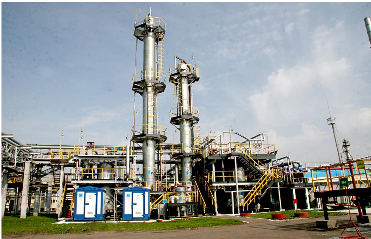
Рисунок 3 – Установка сероочистки
