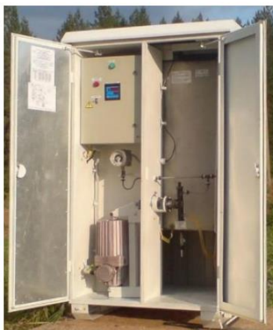
Рис. 9. Устьевой блок подачи реагента
