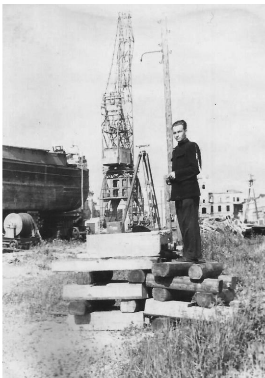
Установка нивелира при снятии упругой линии т/х «А. Щуров»
