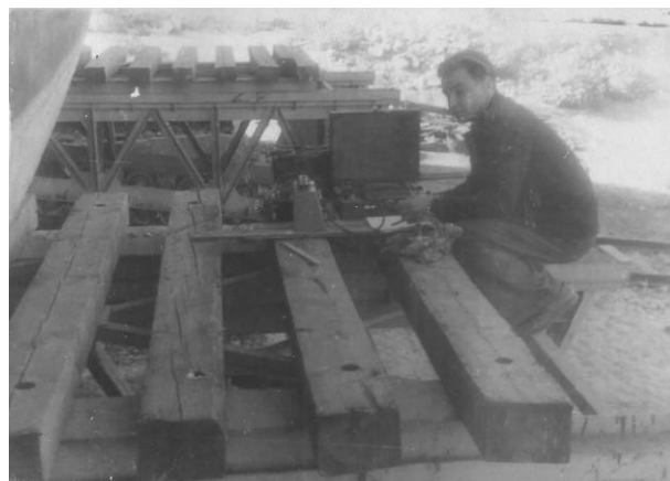
Снятие отсчетов по показаниям тензометрической станции постоянного тока
