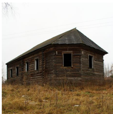
Разрушенная церковь Сорока мучеников Севастийских с. Слободка. 2017 г.
