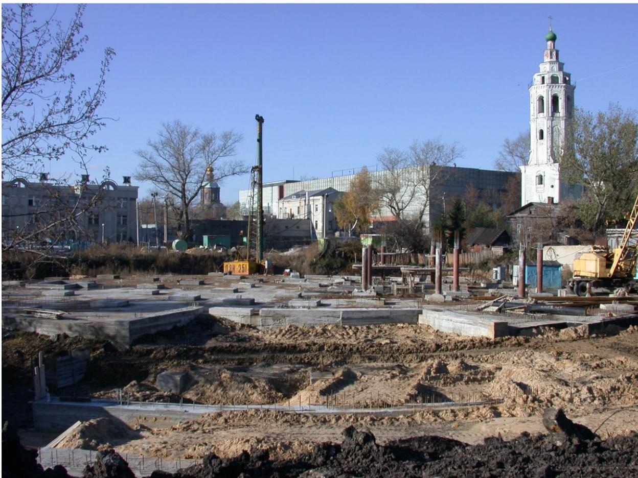
*Рис. 2. Устройство монолитных железобетонных фундаментов, октябрь 2002 г.*
