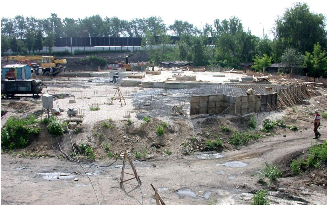
*Рис. 1. Устройство монолитных железобетонных фундаментов, июнь 2002 г.*
