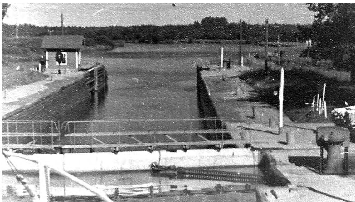
ВОРОТА ШЛЮЗА И МЕХАНИЗМ ДЛЯ ИХ ОТКРЫТИЯ ВРУЧНУЮ
