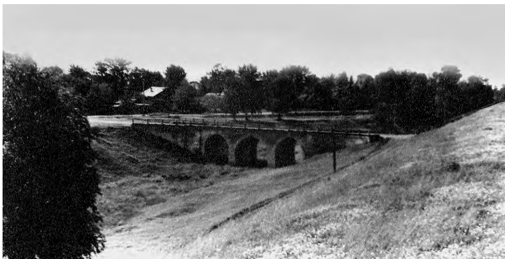
КАМЕННЫЙ МОСТ XIX в. СОЕДИНЯЛ КРЕПОСТЬ С ГОРОДОМ
