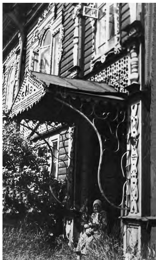
НАВЕС НАД ВХОДОМ
