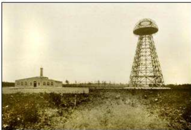
Лаборатория и башня Уорденклиф, снимок 1904 г. (Фото: Wardenclyffe plant-5)
