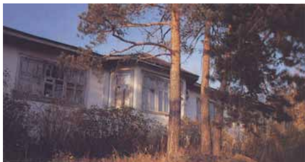
Дом, в котором жили Вернадские в эвакуации в Боровом
