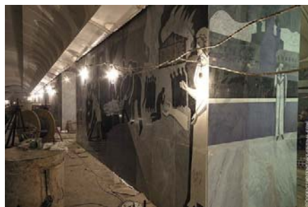
Фото 9а. Станция метро «Достоевская»
