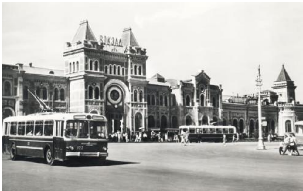
Рис. 3 Пассажирский Железнодорожный Вокзал – первоначальный вид
