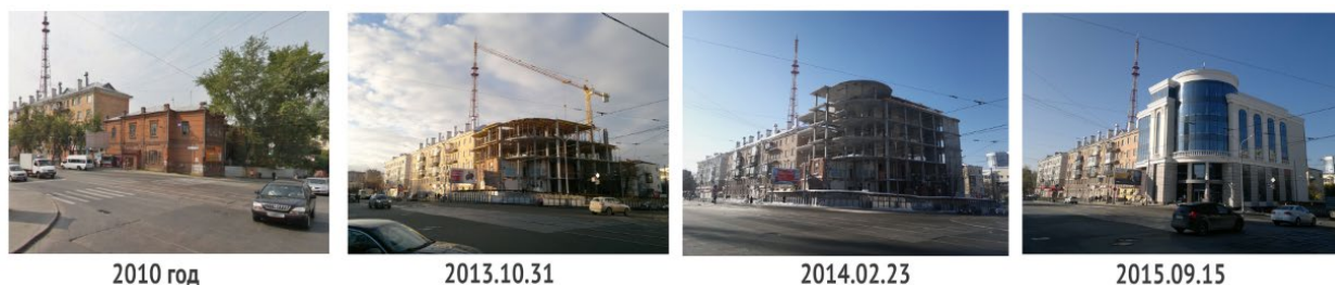
Рис.3. Процесс строительства офисного здания № 210 на ул. Луначарского
