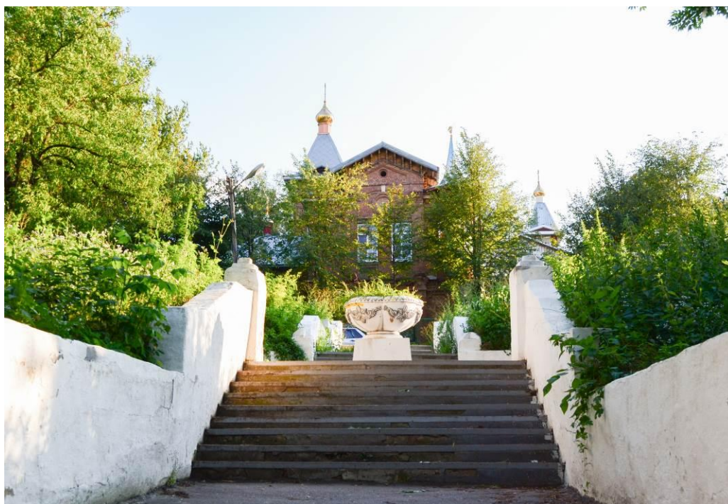
Вид на парковую лестницу и северо-восточный фасад дома Я.Ф.°Николенко.
